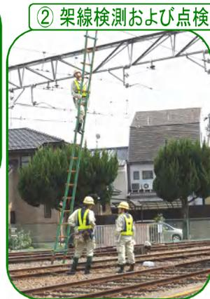
② 架線検測および点検作業
