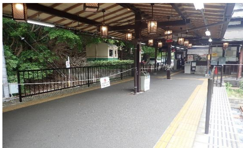
転落防止用固定柵（鞍馬駅）
