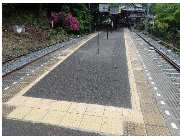
内方線付き点状・誘導ブロック（鞍馬駅）
