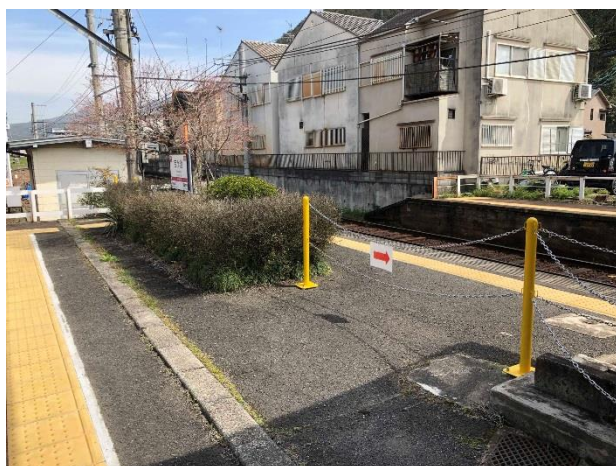
内方線付き点状ブロック（宝ヶ池駅）
