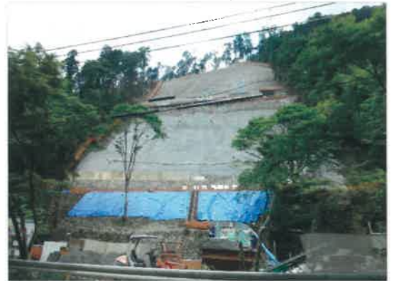
6月下旬の現場の様子
