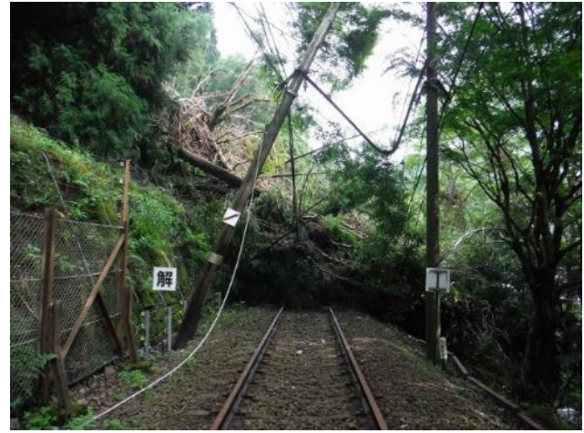
軌道には多くの土砂・倒木が流入
