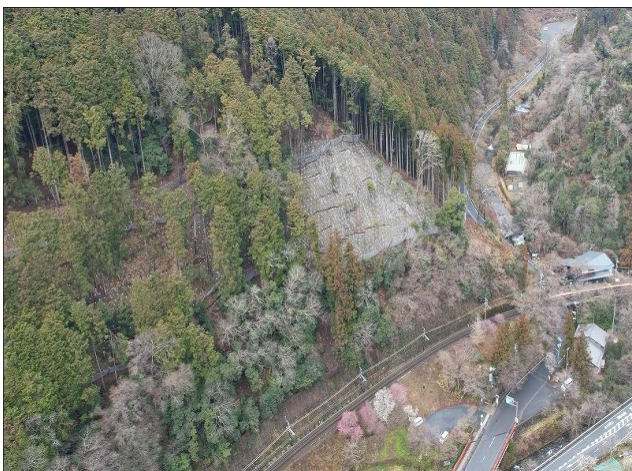
行政による対策工
