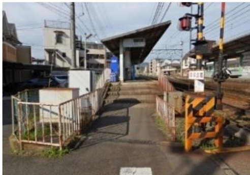
《上下線各ホームのスロープ設置：写真は下りホーム》
