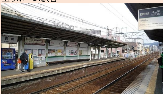
下りホーム駅舎
