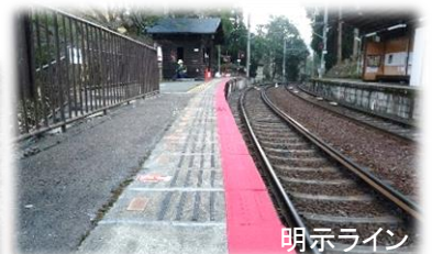
施行後の駅舎
