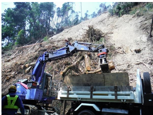
人力で伐採した倒木材の撤去 (2020年8月6日撮影)
