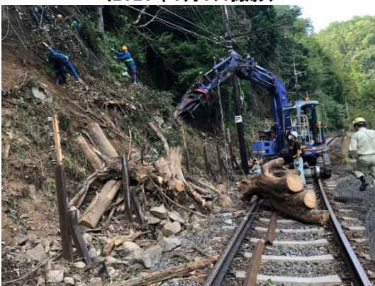
災害箇所周辺の落石防護ネット整備の様子 (2021年3月15日撮影)
