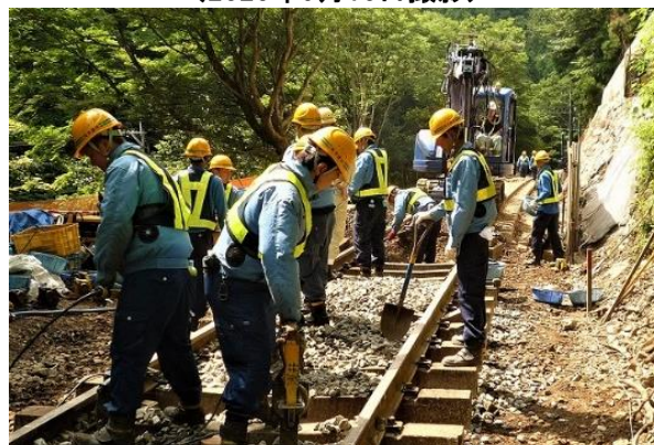
崩壊部の軌道設備復旧の様子 (2021年7月14日撮影)
