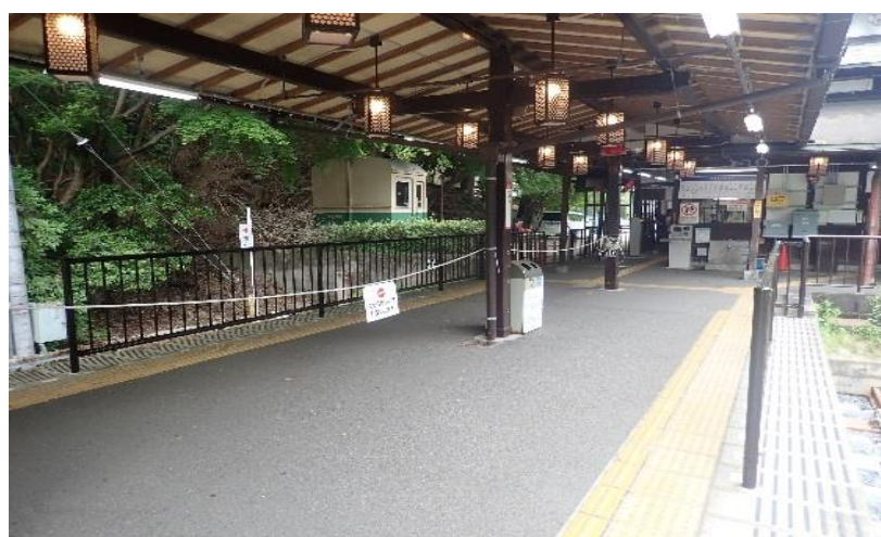
転落防止用固定柵（鞍馬駅）
