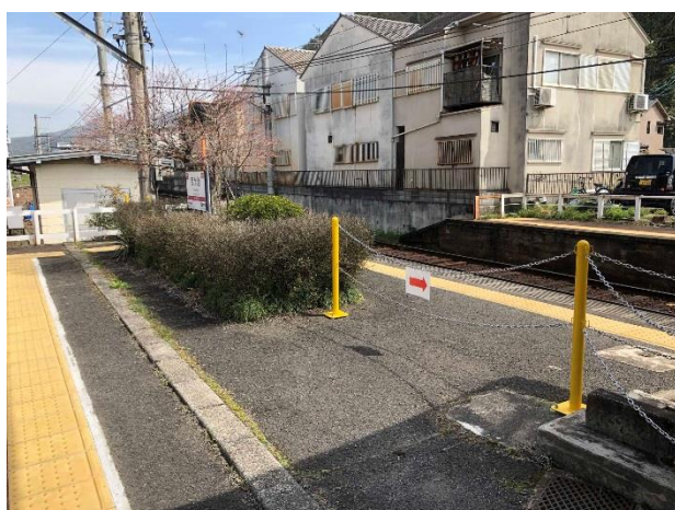
内方線付き点状ブロック（宝ヶ池駅）
